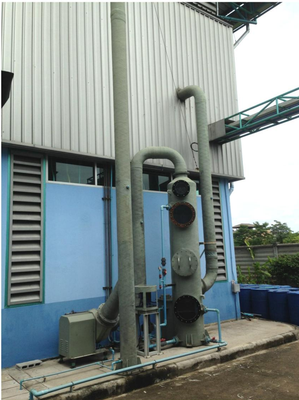
ภาพตัวอย่างระบบดูดไอสารเคมี กลิ่น ฝุ่นผง และระบบบำบัด (wet scrubber)
