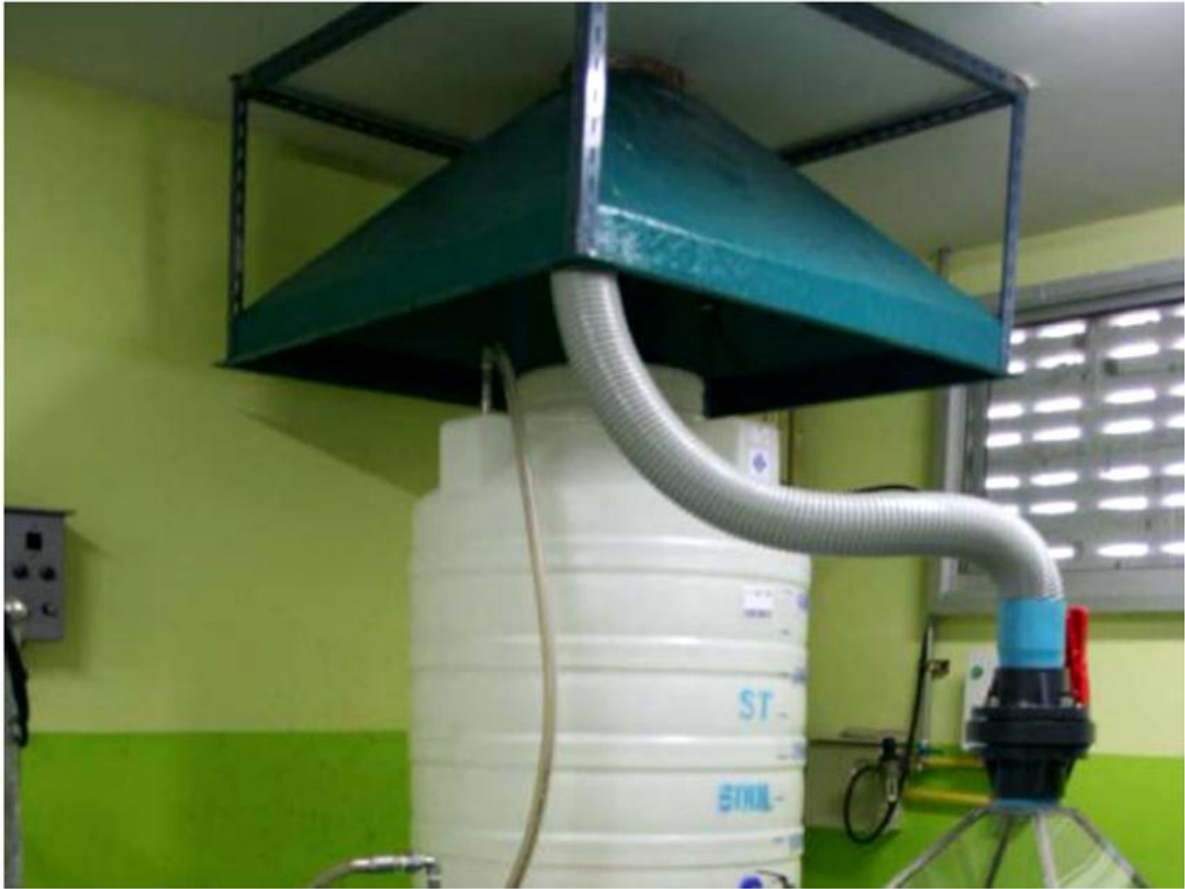
ภาพตัวอย่างระบบดัดไอสารเคมี กลิ่น และระบบบำบัด
